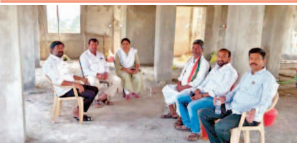
వనశి గృహ భవనం నిర్మాణం పనులను పరిశీలిస్తున్న ప్రత్యేక అధికారి
